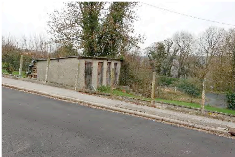
Abris de jardin en agglos nus, visible depuis l'entrée du bourg
