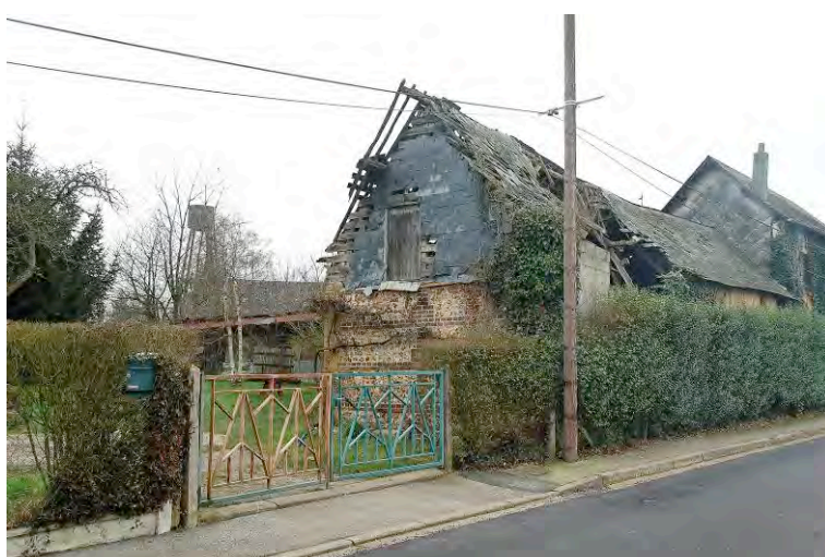
Bâtiment en ruine dans le bourg
